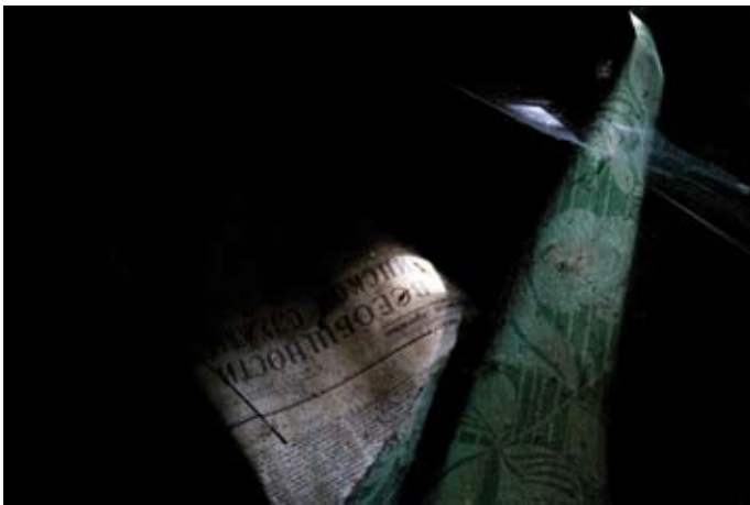
Abgelöste Tapete und darunter zum Vorschein kommende alte russische Zeitungen können bei entsprechendem Licht sogar romantisch wirken...
